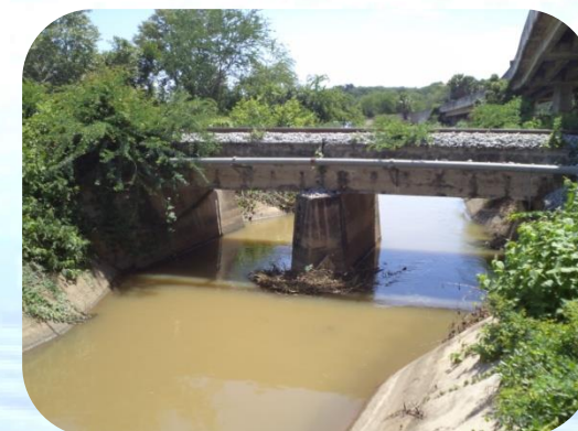
สะพานคอนกรีต
