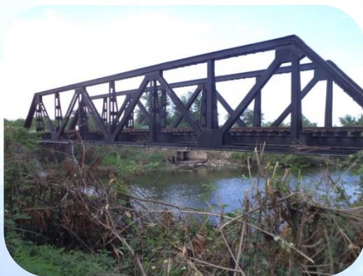
สะพานโครงเหล็ก
