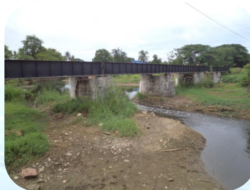
สะพานเหล็ก
